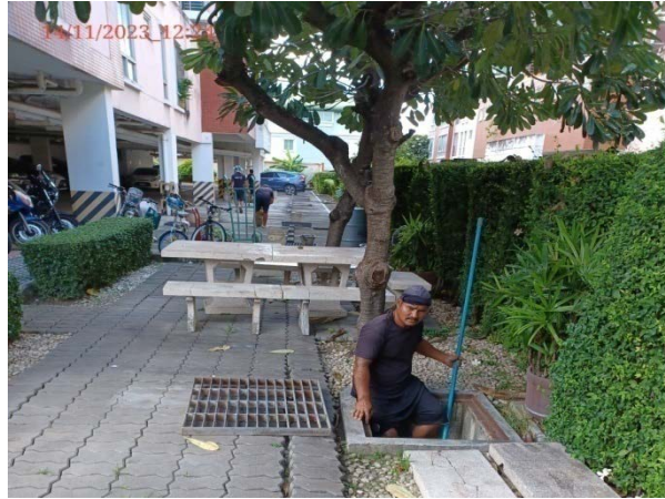
รูปที่ 2-12 การทำความสะอาดระบบระบายน้ำใต้ดิน
