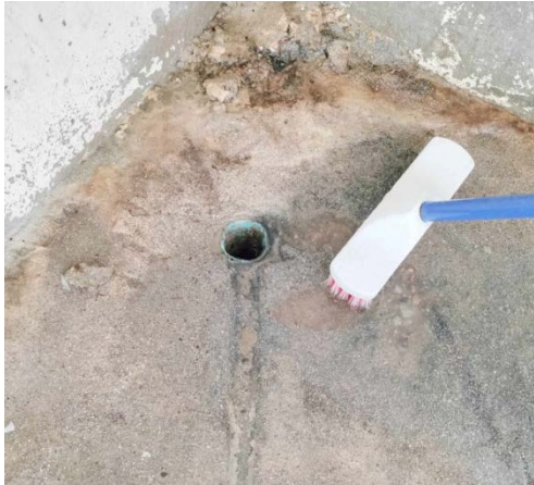
รูปที่ 2-16 ท่อรวบรวมน้ำจากการล้าง ห้องพักรงมูฝอย
